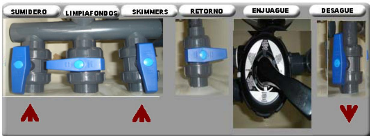
Esta operación es muy breve, de unos 15 a 20 segundos, una vez terminado el ENJUAGUE hay que parar nuevamente el motor y cambiar a la posición de FILTRACIÓN.
