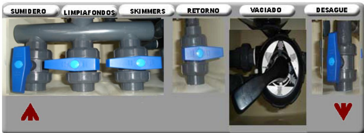
Se recomienda que se vacíe la piscina completamente antes de parar la bomba. si se para antes de terminar de desaguar la bomba no puede aspirar nuevamente hay que vaciar la piscina de una sola vez
